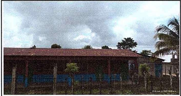
Foto 2 : Se observa las laminas deterioradas a sustituir.
