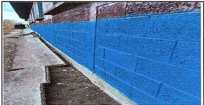
Foto 6: Se observa la torta de concreto detrás de las aulas.
